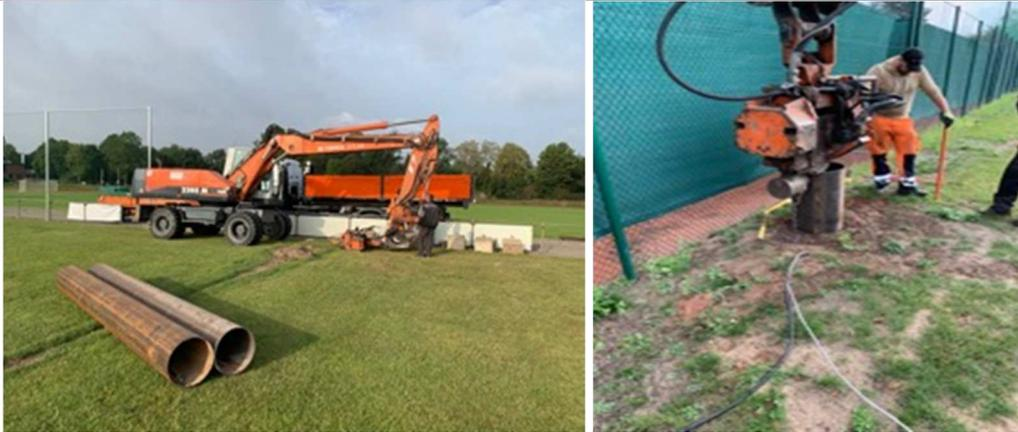
Gründung der Flutlichtmasten durch eine zerstörungsfreie Rammrohrgründung. So werden die Flutlichtmasten nur noch in die Stahlrohre eingesteckt und können auch in Zukunft bei Bedarf sehr leicht versetzt werden. Neuer Stromanschluss für die Außenanlagen (D-Platz, vor der Sauna rechts) um Überlastung des vorhandenen Hausanschlusses zu vermeiden und zur Gewährleistung eines reibungslosen Parallelbetriebes der gesamten Flutlichtanlage + Wettkampfbüros.
